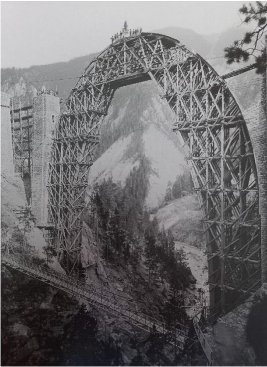
Am 1. August 1908 versammelten sich die Arbeiter im Scheitelpunkt des Lehrgerüsts für den Wiesner Viadukt zum Aufrichtfest.
