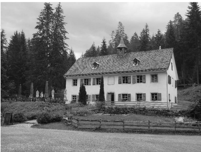
Bellaluna im hintersten Winkel des Albulatales sollte wegen der Nähe zum Engadin zur Kopfstation der Bahn werden. Hier das Direktionsgebäude des ehemaligen Bergwerks.
